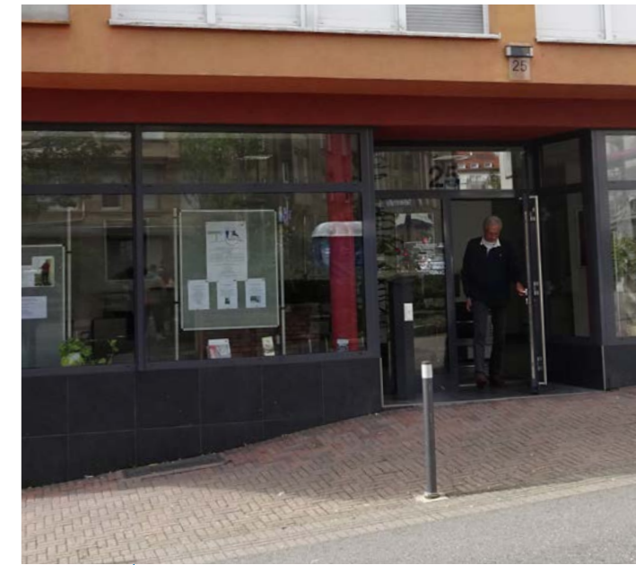
Die barrierefreie Geschäftsstelle in einem ehemaligen Lebensmittelmarkt trägt die Handschrift des Architekten Müller. Fotos: © Kleusch
